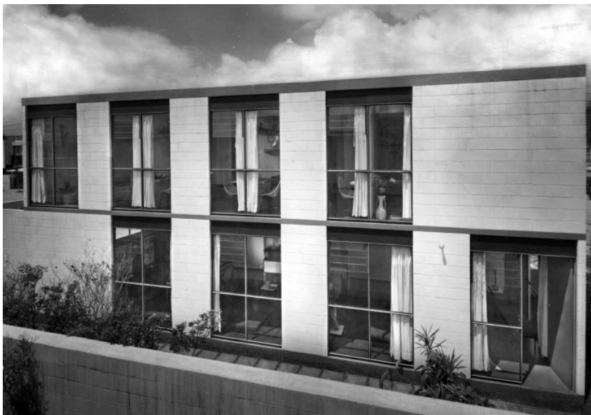
La obra fue realizada sin desperdicio de material y rápidos sistemas constructivos.
